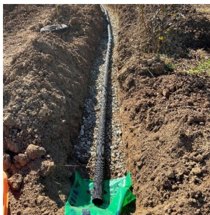
(写真5) 暗渠排水路敷設の様子
