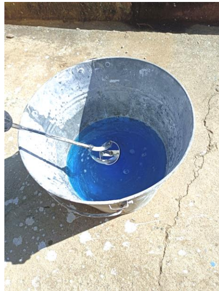
写真. ドリル先端に攪拌機を付けて硫酸銅を溶かす
