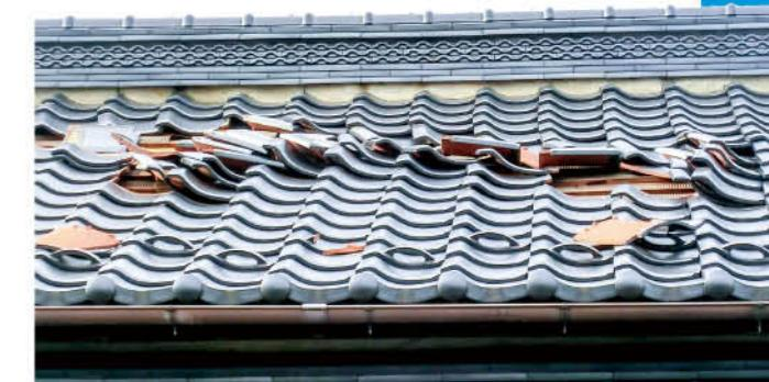
令和元年の台風19号により破損した瓦屋根
