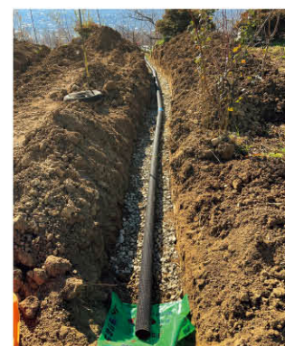
【図2】暗渠排水路
